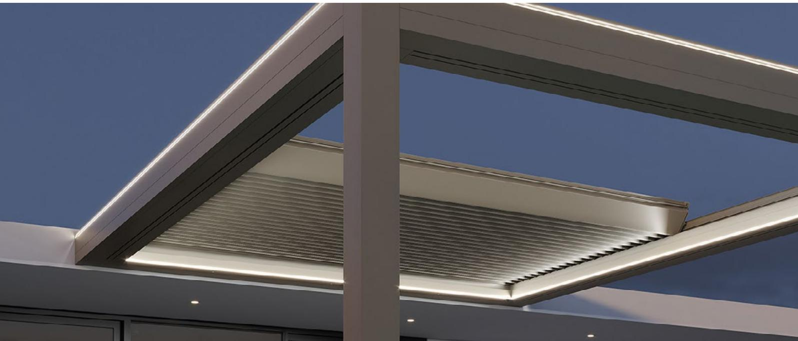
Beleuchtung spielt eine wichtige Rolle um die Pergola zu jeder Tageszeit nutzen zu können. KE verwendet LED-Streifen und integriert sie perfekt in die Strukturprofile. Die gewählte LED-Technologie ermöglicht einen niedrigen Energieverbrauch, vielfältige Einstellungen, sowie Farbwechsel und Intensitätsanpassungen mit Hilfe einer leichtverständlichen Fernbedienung.
