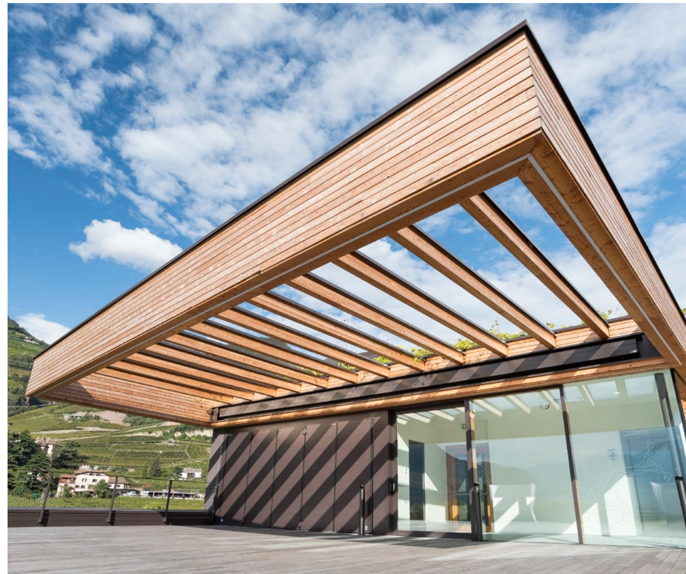
LUOGO PLACE: BOLZANO _ COMMITTENTE/CUSTOMER: PRIVATO-PRIVATE _ PRODOTTO/PRODUCT: QUBICA PLUMB
